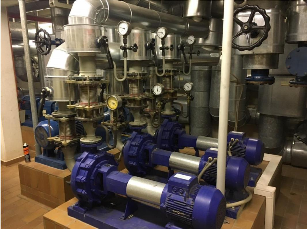
Abb. 39 | Wärmeverteilung in der Nahwärmezentrale
