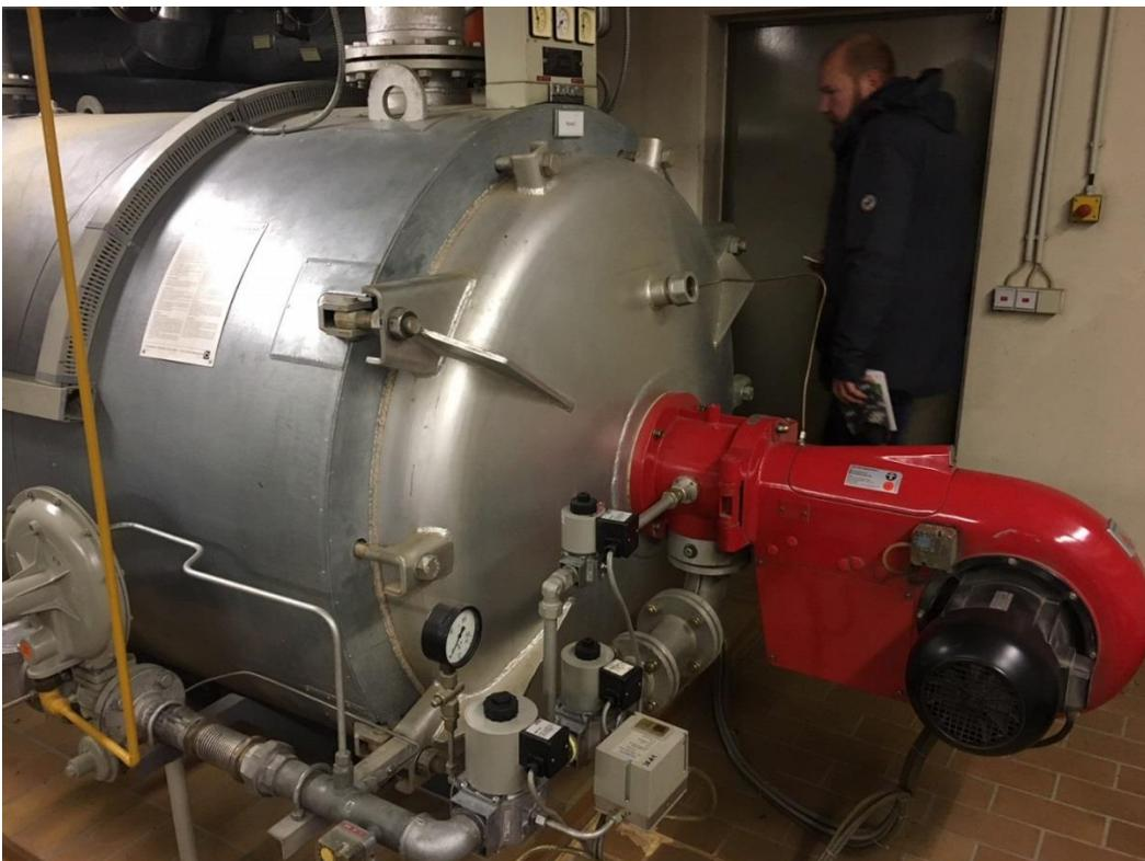
Abb. 40 | Wärmeversorgung in der Zentrale, Kessel Baujahr 1987
